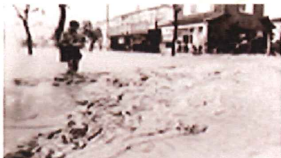
昭和49年 高橋川水害(額新町付近)
