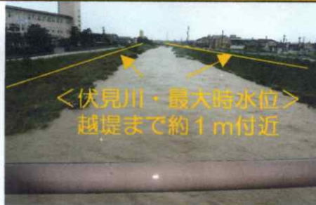
<伏見川・高橋川合流地点>
